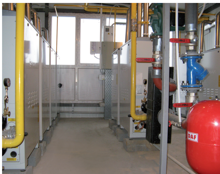
Рис. 6 Крышная котельная гостиничного комплекса
