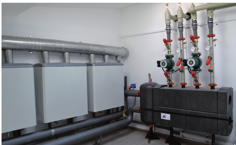
Рис.2 Крышная котельная ресторана, 360 кВт
